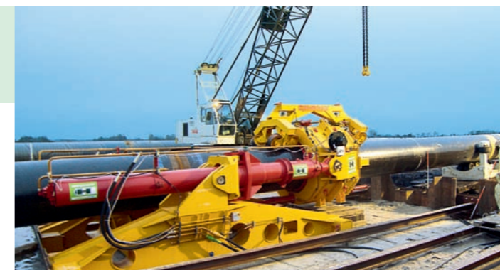
Zusätzliche Schub- und Zugkraft beim Rohreinzug mit dem Pipe Thruster.
